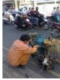
Hình 4.1b: Sử dụng bình gas cạnh lò nấu sơn
